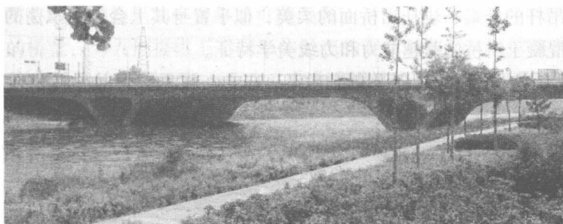
图 1.3 石家庄市友谊大街桥（跨度 35\text{m}+55\text{m}+35\text{m} ，双幅总宽度 49.6\text{m} ）
