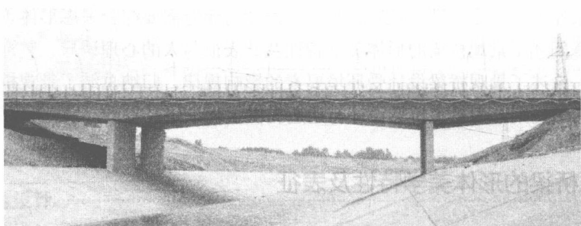
图 1.1 邢峰线跨南水北调中线总干渠预应力混凝土连续箱梁桥
