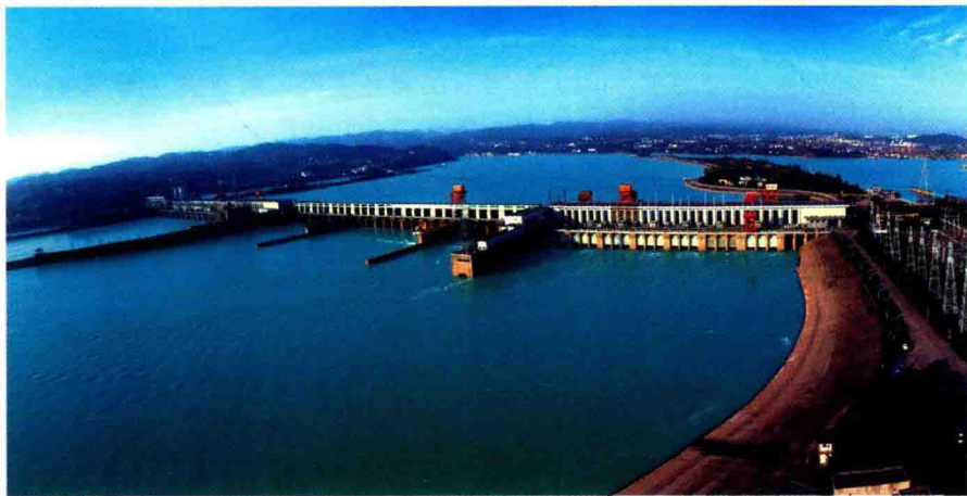
图 1.1-1 葛洲坝水利枢纽鸟瞰图
