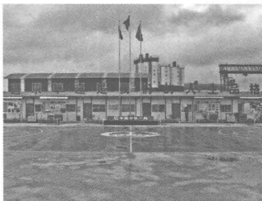
图 1-22 制梁场办公生活区 2
