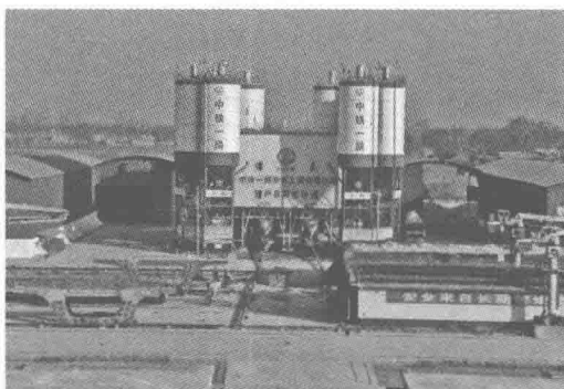
图 1-16 制梁场拌和站 2
