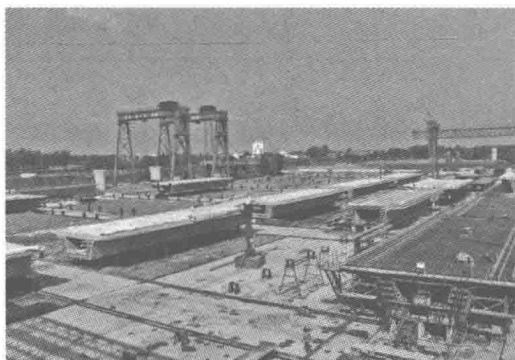
图 1-11 箱梁场存梁区
