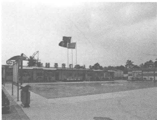
图 1-21 制梁场办公生活区 1
