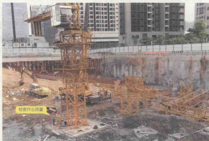
图 1.6-2 管理人员现场检查作业质量
