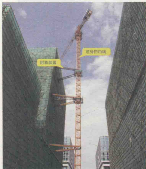
图 1.7-2 塔式起重机附着装置设置
