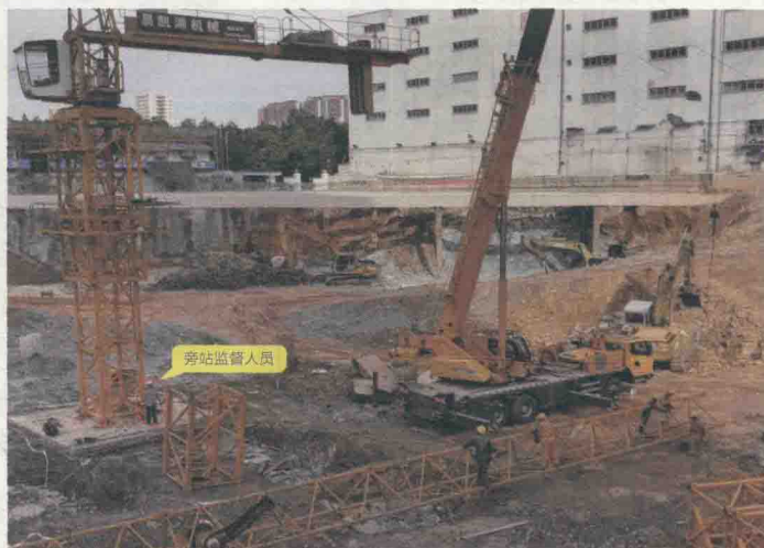
图 1.6-1 管理人员现场旁站监督作业
