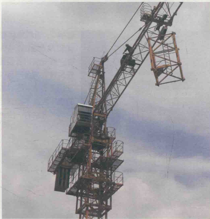
图 1.7-1 特种作业人员顶升加节作业
