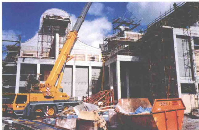
图 1-9 建筑工地——环境建设是多学科的融合
