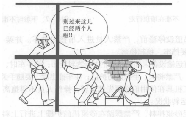
图 1-4 同一块脚手板上不超过两人
