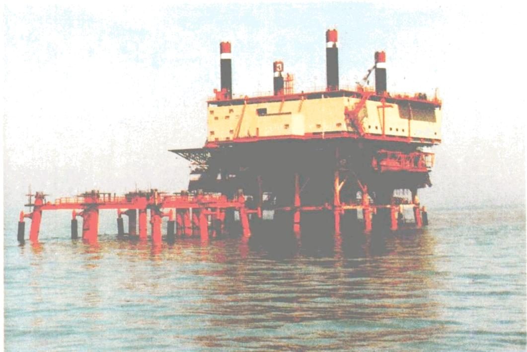
国营大连造船厂制造的埕北油田 A 区生产模块，是一座海上原油处理平台，可把从海底开采的原油，处理成合格的商品原油。该模块为国内首次建造的具有 80 年代国际先进水平的大型海上石油生产平台。
