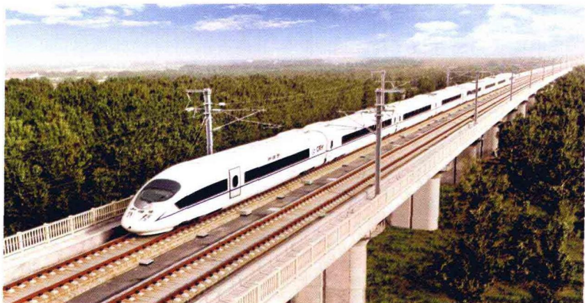
图 1.2 时速 350 km 的京津城际铁路
