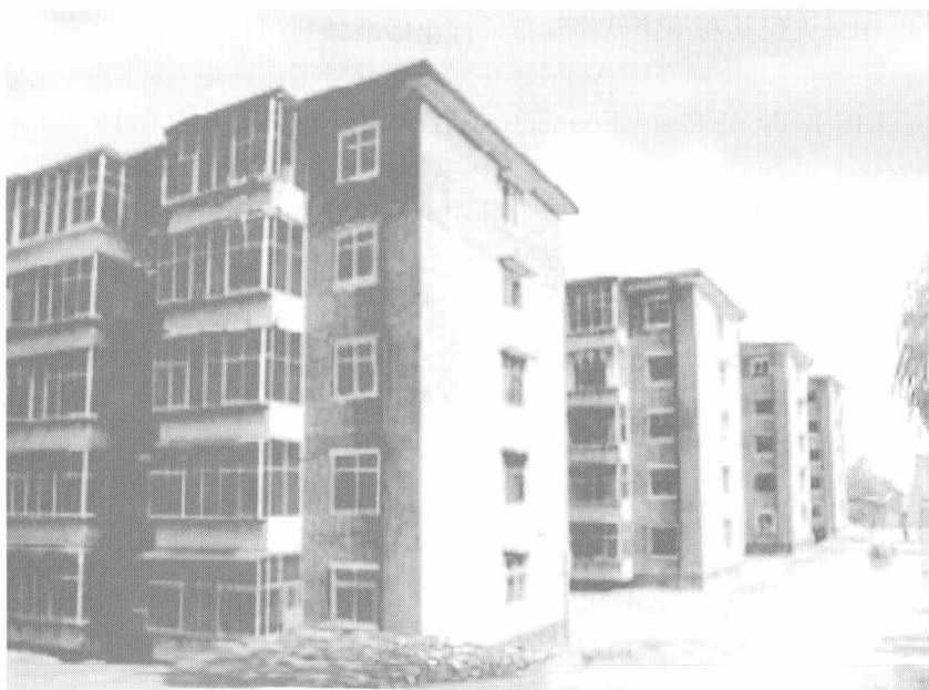
图 1.2.1 中国天津的世界第一座轻骨料混凝土模壳格构式住宅楼
