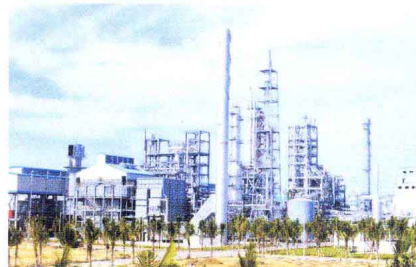
中国海洋石油海南45万吨合成氨装置 (中国最大的合成氨装置)
