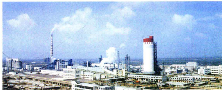
陕西渭河煤化工集团有限公司——30万吨合成氨、52万吨尿素
