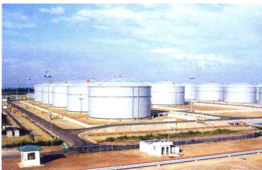
斯里兰卡国家石油公司石油罐群
