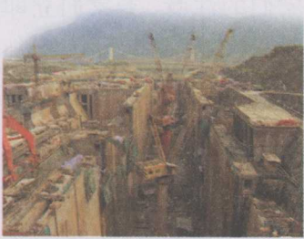
建设中的三峡大坝工地
