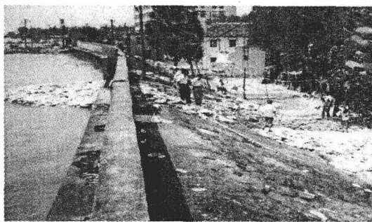
图0-9 长江堤防武汉段 在1998年大洪水时发生多处渗透变形
