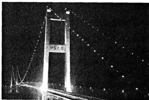
图 1.9 江苏江阴长江公路大桥
