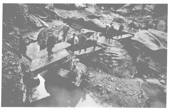
二溪口石桥 位于盐津县普洱镇水洞村,因处于两溪交汇处而得名。始建于清乾隆三十二年(1767年),后多次维修。为五孔石梁桥,桥墩全部利用溪中巨石,上铺条石为梁,通长约20余米,宽约1米,每孔跨径不等。桥墩不在一条直线上,自然形成"曲桥",距水面约高1.6米。
