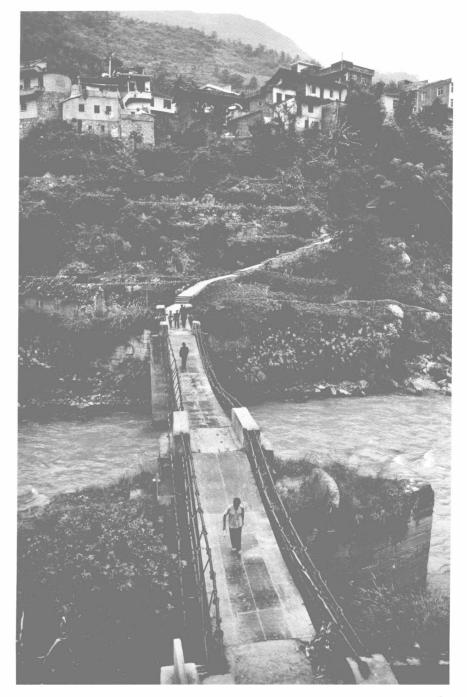
黄葛铁链桥 位于昭通市大 关县黄葛乡东北约100米处的古驿 道上。始建于清道光十三年(1833 年),光绪年间重修。为三孔铁链 桥,全长40米,宽2.5米,距水水 高约10米,由10条铁链组成,6条 为底链,4条为护栏。铁链为单根 锻造而成,每扣长约30厘米。
