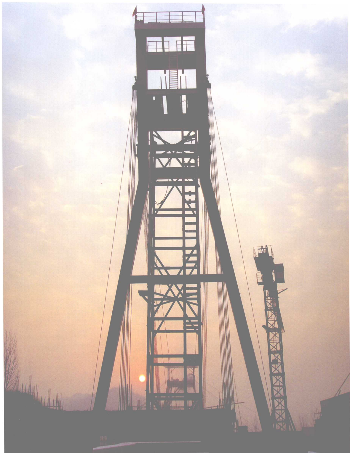
鲁南矿业地下开采副井永久性井架
