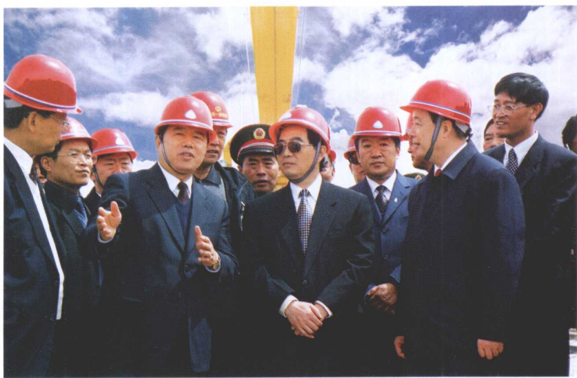
2002年5月27日，胡锦涛同志在青藏铁路南山口建设工地视察
