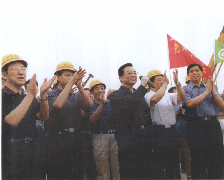
2002年6月21日，温家宝同志视察陇海铁路灞河桥复建工地
