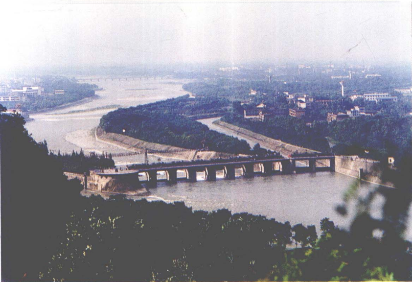
都江堰水利工程
