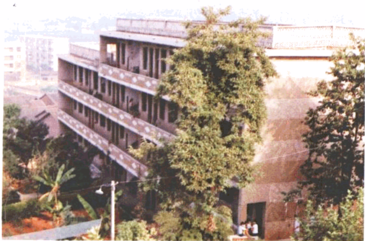
◀ 常宁县第二中学实验楼
