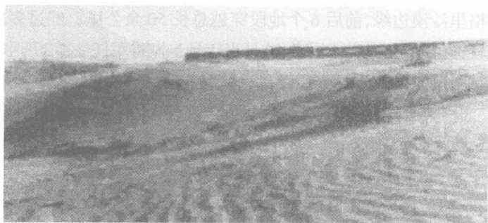
我国第一条沙漠铁路,1958年8月1日建成通车,1958年10月正式投入运营。图为列车从腾格里沙漠南边缘——沙坡头地段通过的情形
