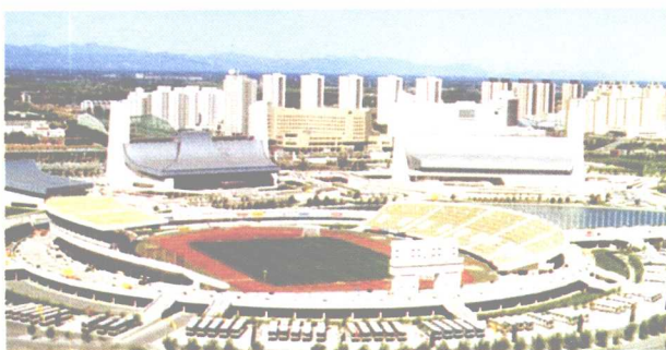
亚运村体育中心，田径场和游泳馆。
