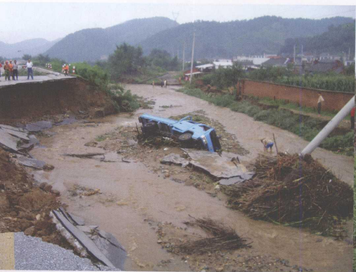
抚顺县被水毁的双古线公路。
