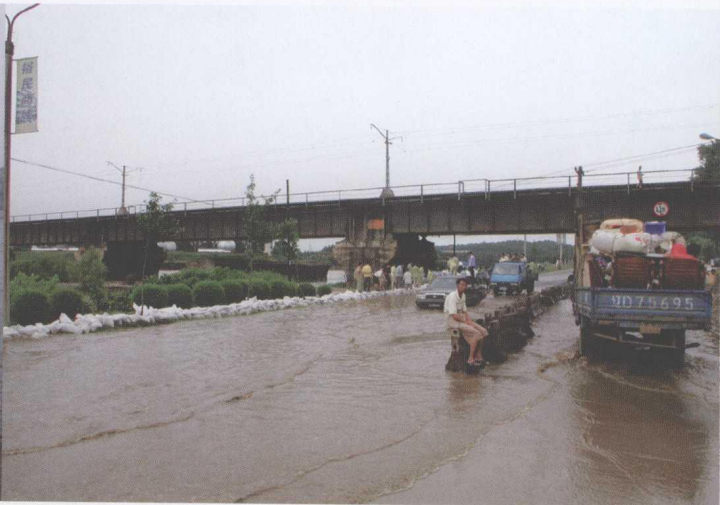
东洲区电铁桥下公路大量积水。
