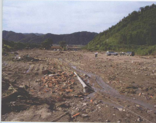
洪水将清原小山城村大片民房夷为平地。↓
