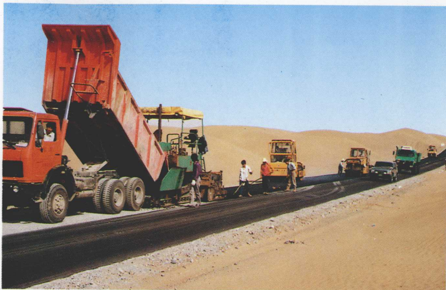
□ 筑路队伍在成功的沙基和砾石路面上铺筑沥青。（王兆霖 摄）
