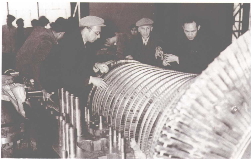
1958年9月28日，黄毅诚（右一）在国内第一台2.5万千瓦汽轮机总装现场。
