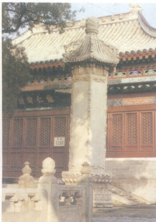
能仁寂照大殿前经幢近景
