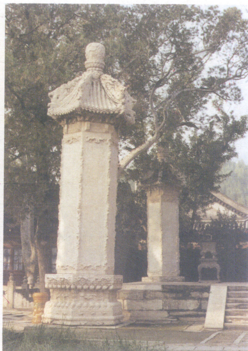
能仁寂照大殿前经幢全景
