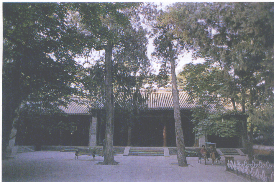
静演三车殿正面全景
