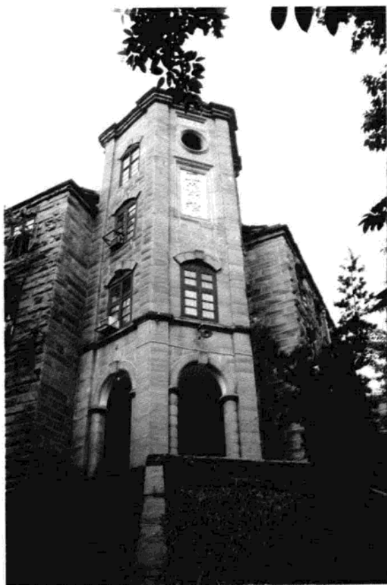
重庆大学工学院楼。(1935 年建成)
