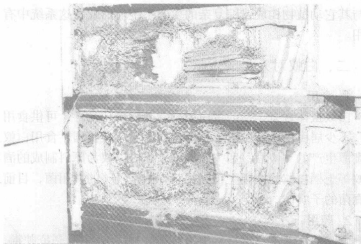
图 1-2 台湾乳白蚁在某银行保险柜内营巢为害状 (作者，1997 年 7 月摄于深圳)
