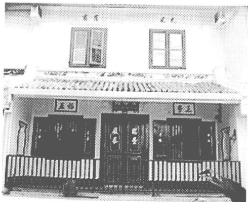
马六甲早期的街屋前落上下层面齐，而腰部出厦构成一楼的前廊。从外观看来，有如二楼退缩。
