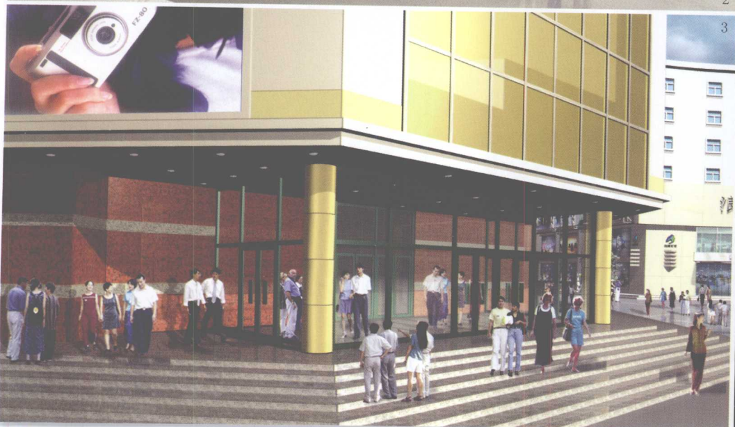
图 1. 苏州某商厦左侧入口处 图 2. 青州商厦左入口一 图 3. 青州商厦左入口二
