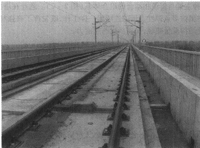
图 2-9 板式无砟轨道
