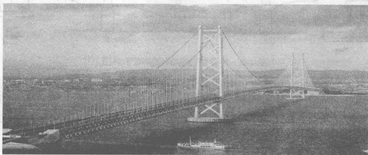
图 1-6 日本明石海峡大桥
