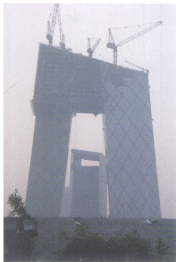
建设中的央视大楼
