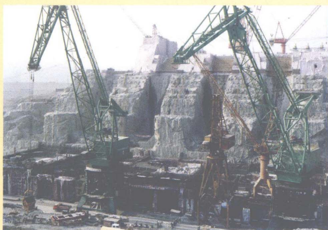
建设中的三峡水电站厂房
