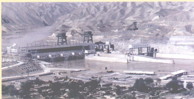
黄河大峡水电站工程
