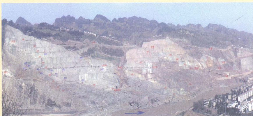
金沙江向家坝左岸300m以上边坡开挖支护工程
