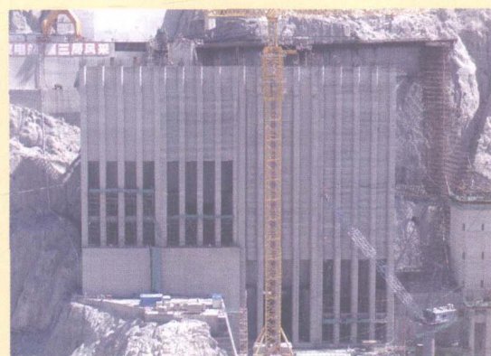
青海拉西瓦水电站进水口工程
