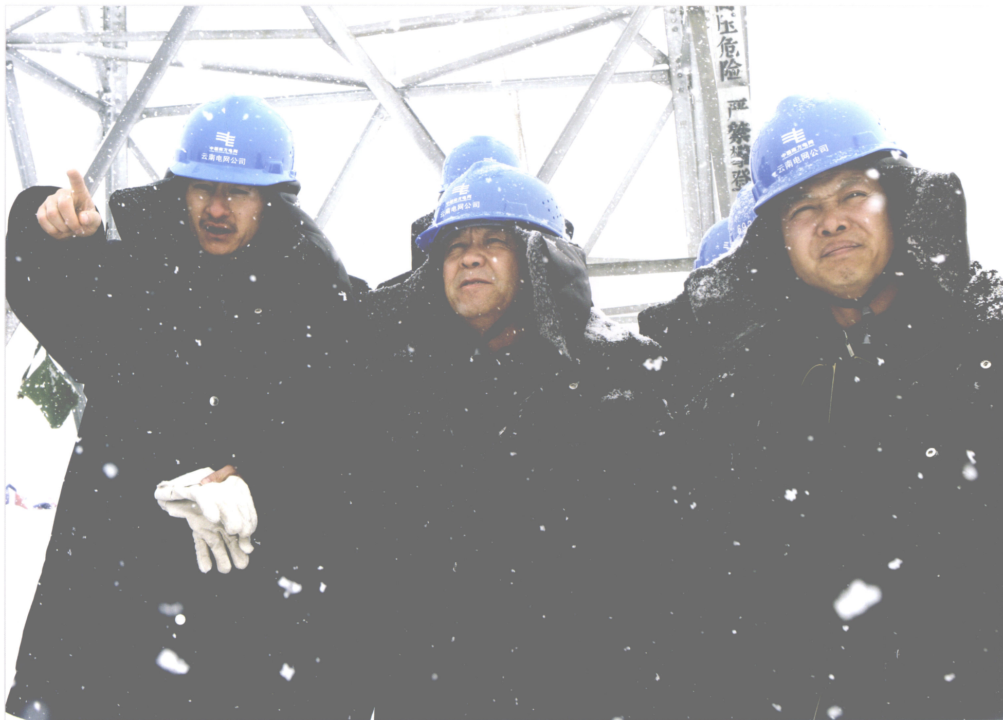
云南电网公司总经理廖泽龙（左二）率队到抗冰救灾现场检查指导工作
