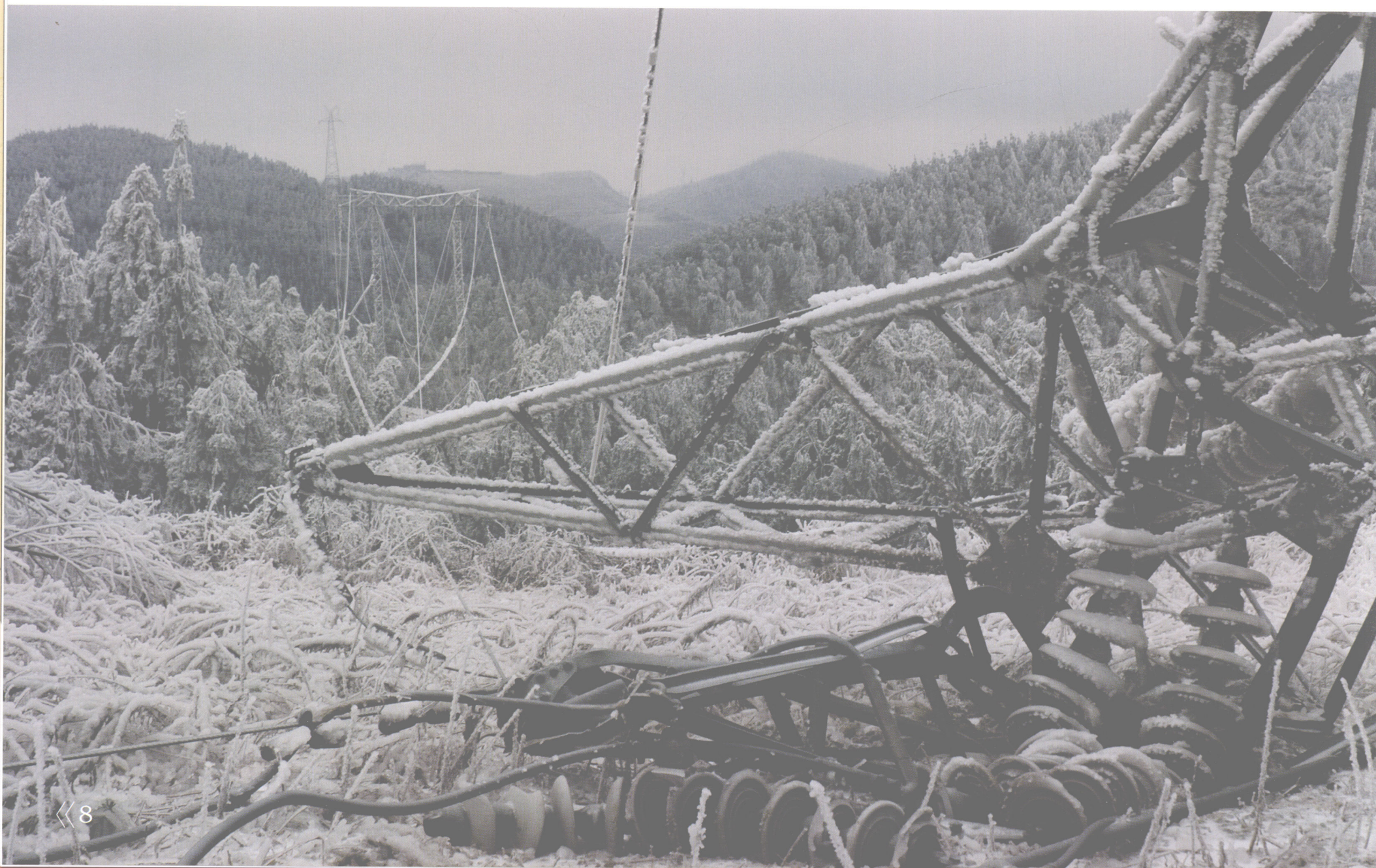
无法承受冰重而倒塌的铁塔
