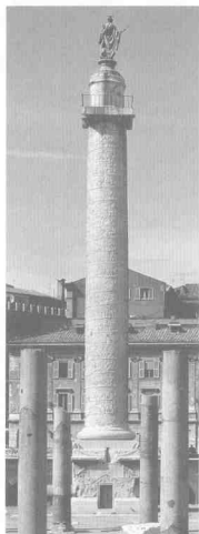
图 1-2-12 古罗马图拉真记功柱
