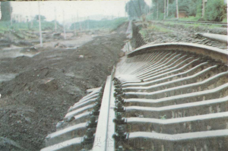
被洪水冲毁的铁路
