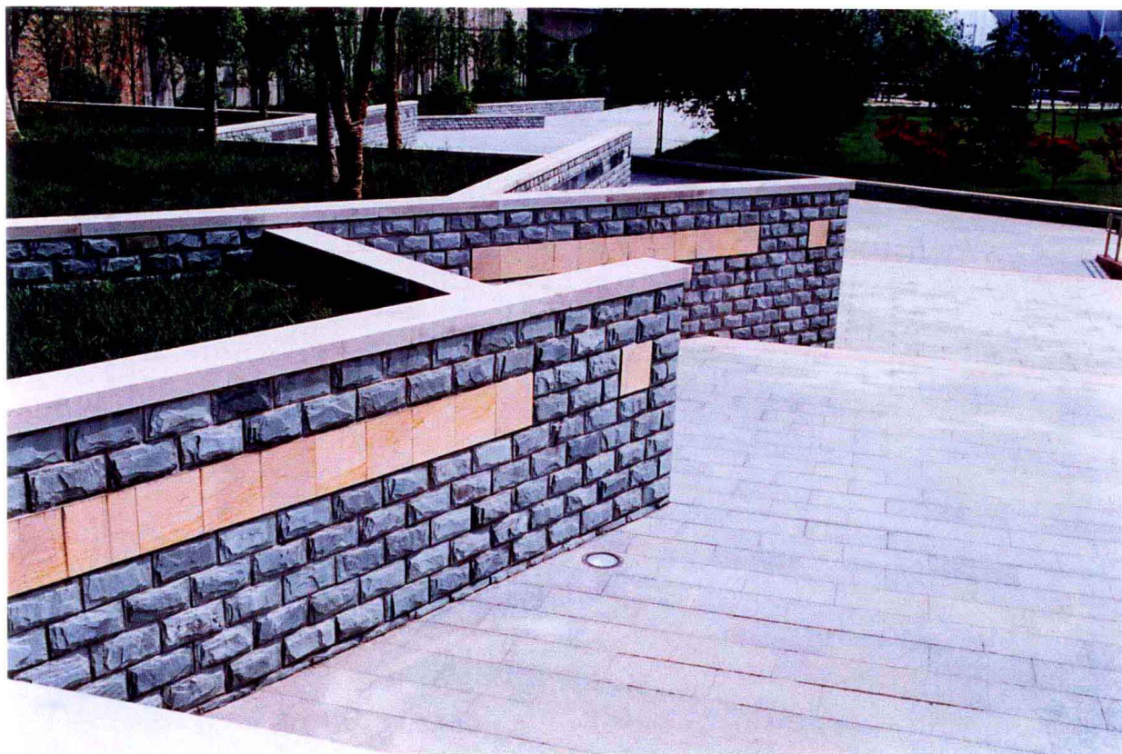
▲ 平面布局上呈现不规则的挡土墙设计,一部分墙体穿插于绿地之中,独特的造型使这一组挡土墙成为景观的重要组成部分。
