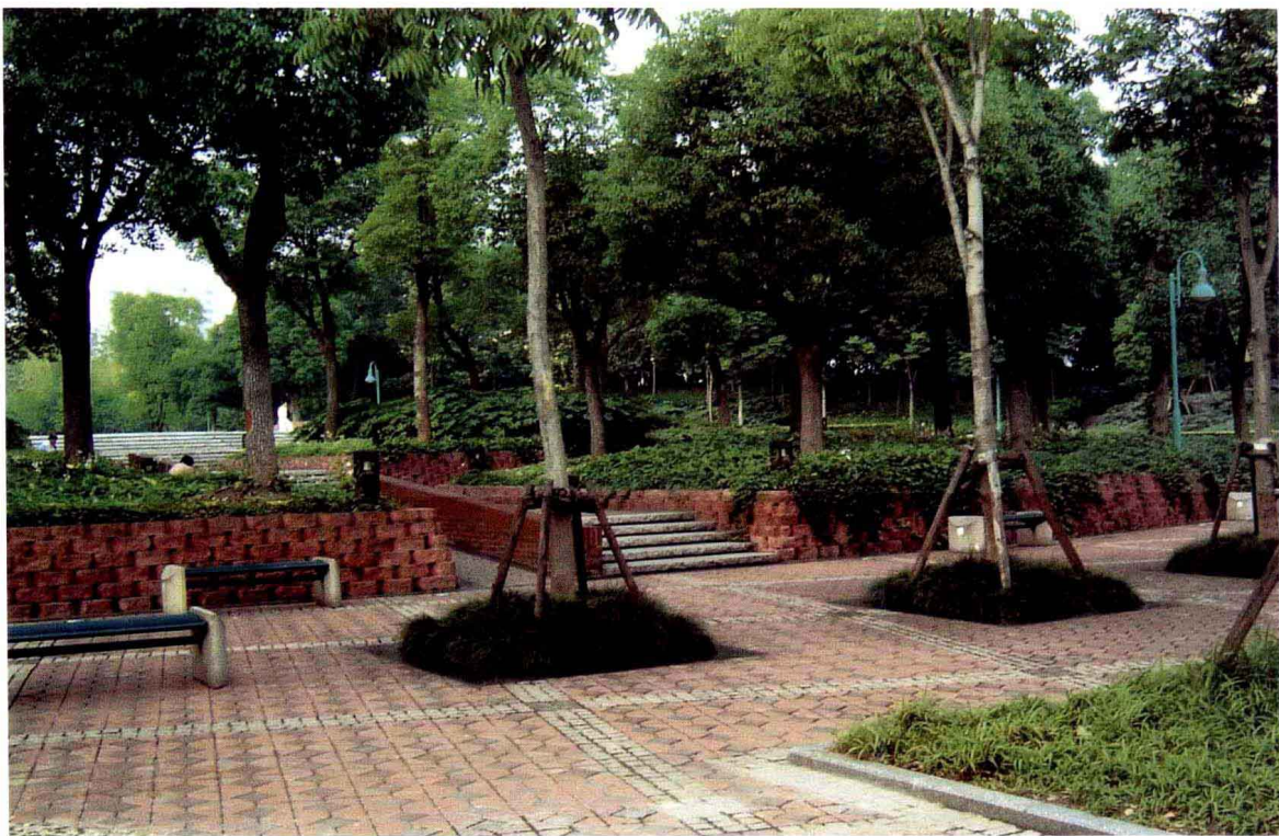
▲ 用透气、透水的苏布洛克砌块砌成挡土墙体,粗犷而质朴。这类砌块不可用做高大的挡土墙,但在低矮的坡脚、驳岸等处却大有作为。
