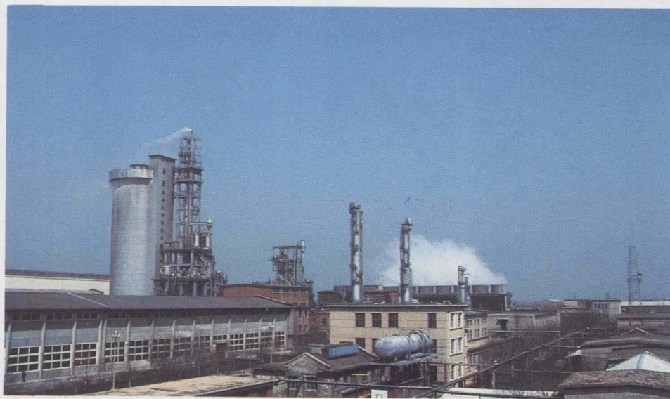
辽河化肥厂尿素 生产设备——造粒塔
