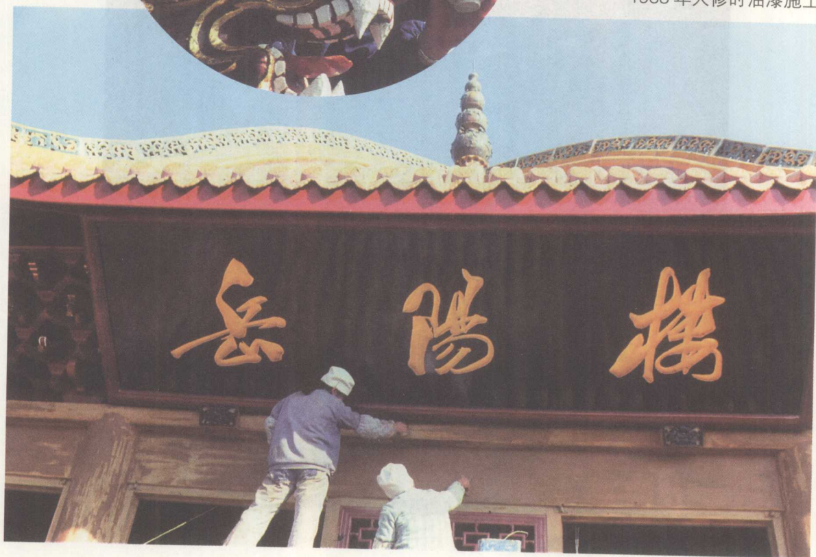
1983 年大修时油漆施工
