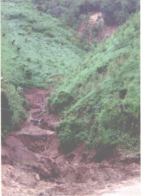
山坡型泥石流沟
