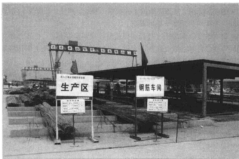
图 2.2 钢筋加工、存放场地
