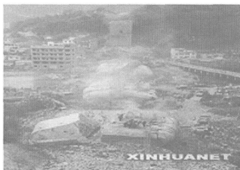
图 1-4 湖南凤凰县堤溪段大桥垮塌
