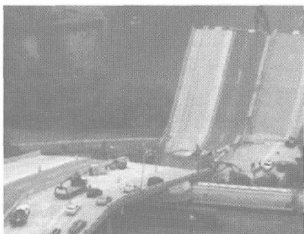
图 1-3 美国明尼苏达州阿波利斯桥梁坍塌
