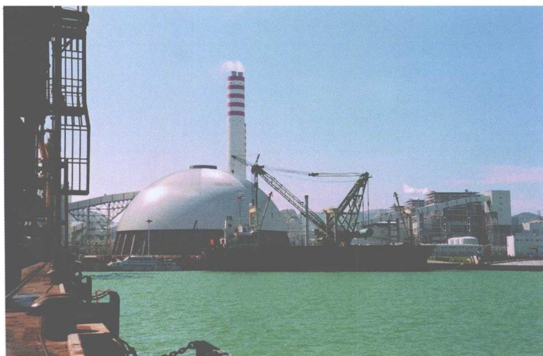
由台商王永庆先生独资兴建的漳州后石电厂，装机 6 \times 60 万千瓦，由省调直接调度
