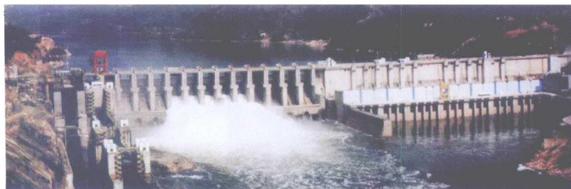
由省调直接调度的水口水电厂装机 7 \times 20 万千瓦
