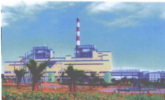
多方集资 兴建的厦门嵩 屿电厂，装机 2 \times 30 万千瓦， 由省调直接调 度
