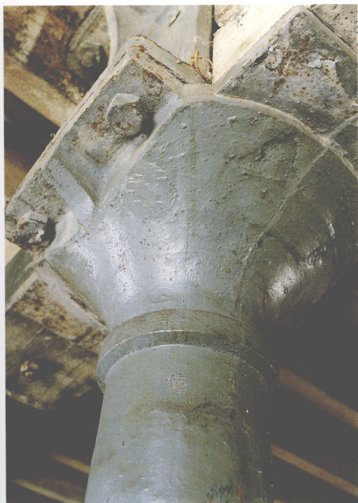
1860年以后，铸铁柱子开始被用做大型仓库的结构支撑
