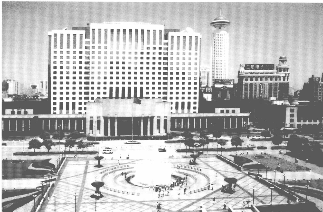
上海市人民政府人民大道办公楼（1995年7月～）
