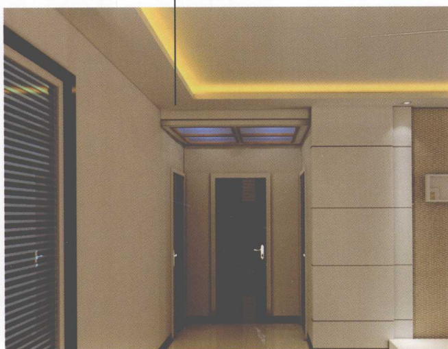
石膏板吊顶，乳胶漆饰面
