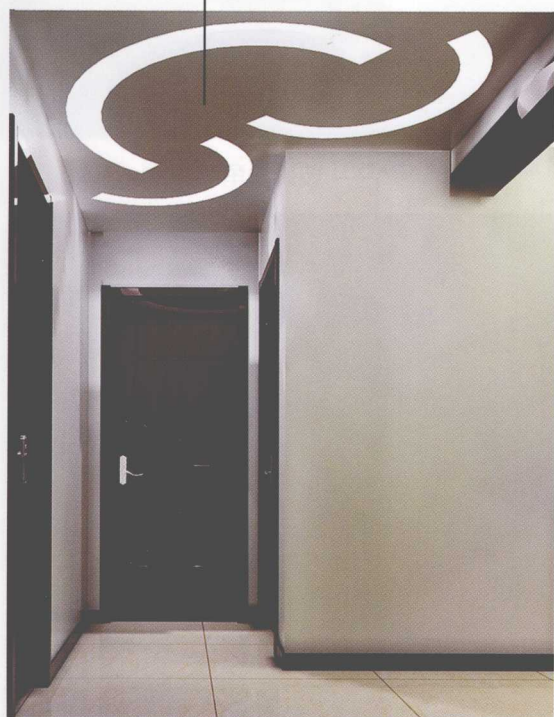
石膏板吊顶，乳胶漆饰面
