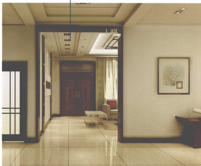
石膏板吊顶，乳胶漆饰面
