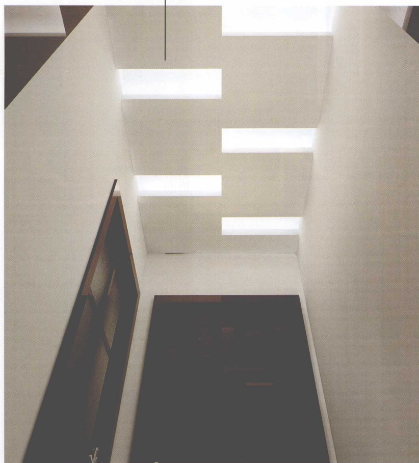
石膏板吊顶, 乳胶漆饰面
