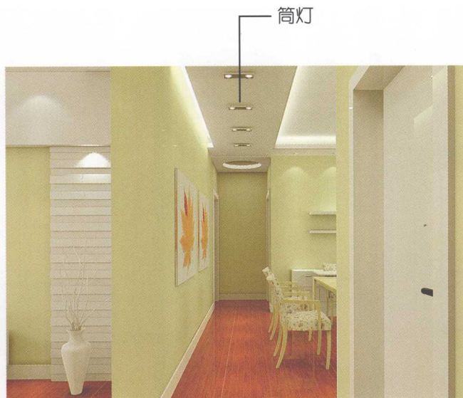
石膏板吊顶，乳胶漆饰面
