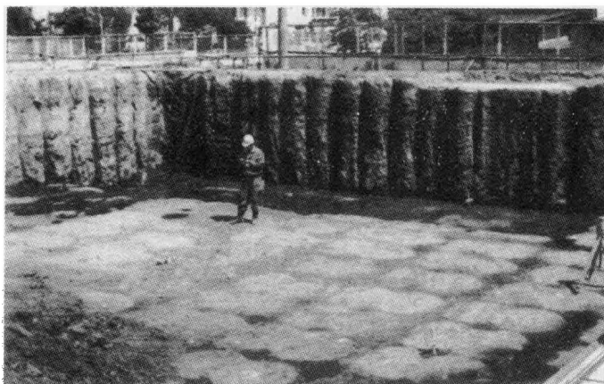
图 10 加固体顶端开挖状况
