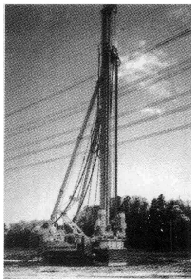
图 3 粉体系(DJM)施工机械
