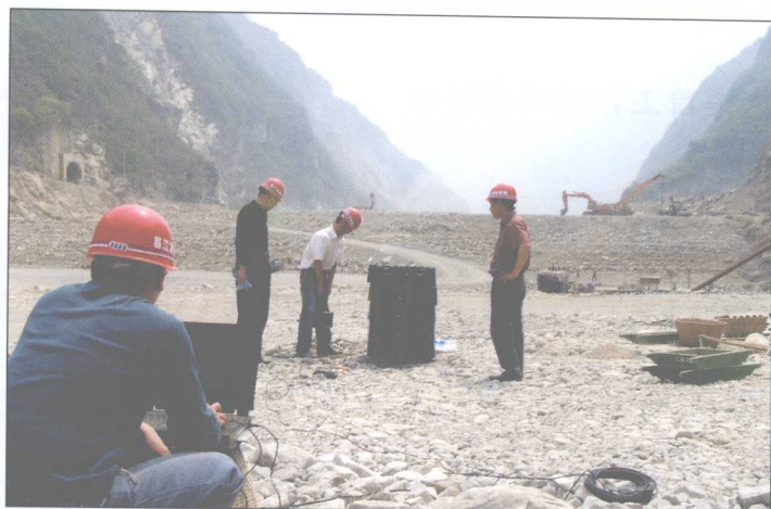
■ 堆石坝工程密度检测现场作业图（法码）
