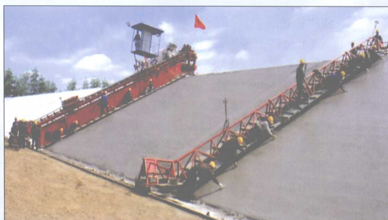
■ SM系列振捣滑模衬砌机（南水北调中线工程）
