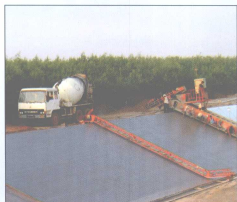
■ SM7000型振捣滑模衬砌机在南水北调东线济平干渠施工中
