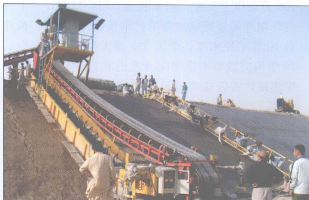
■ SM系列振捣滑模成型设备（巴基斯坦卡其水渠）
