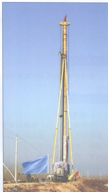
■ BJS-L50型装备主机在施工现场
