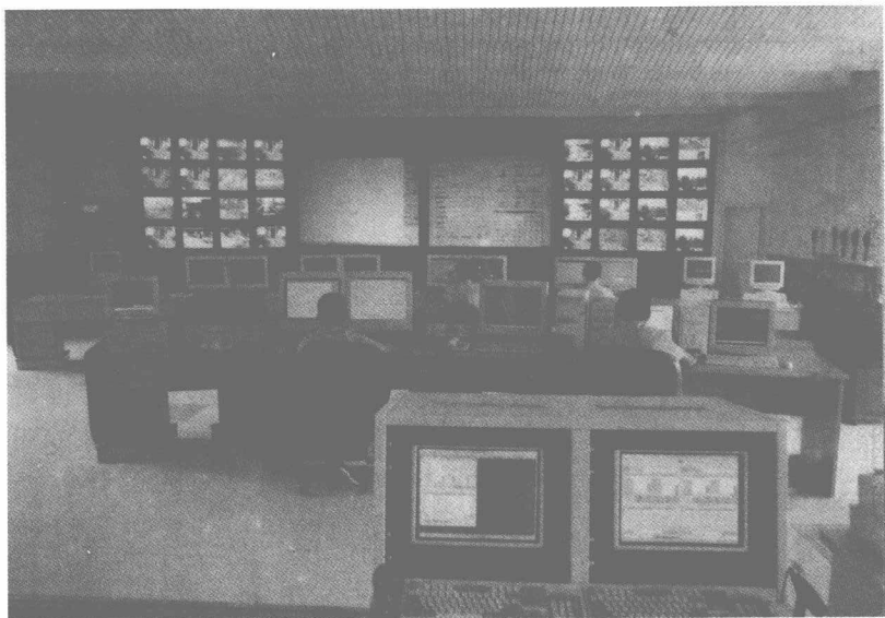
沈阳市消防调度指挥中心
