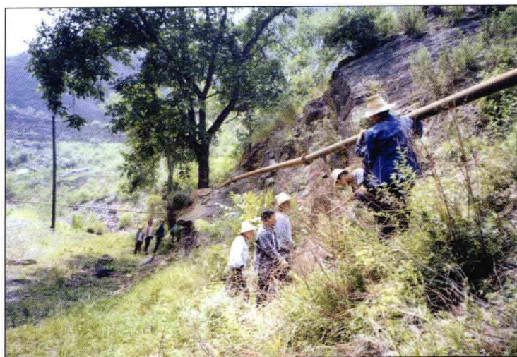
南窖乡水峪村架设管路引水上山
