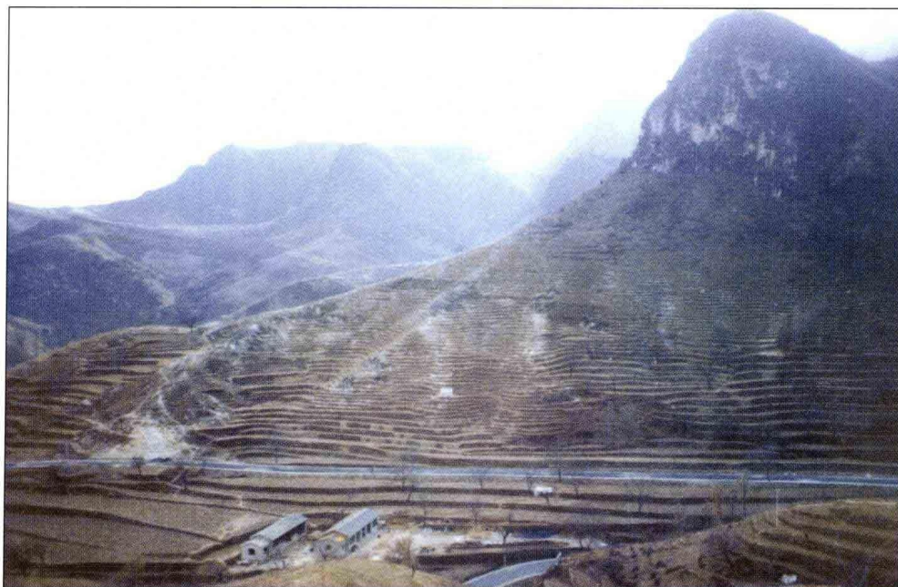
霞云岭分四马台村水土保持工程
