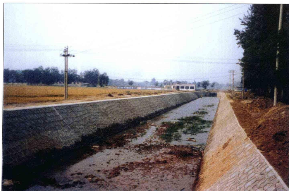
长阳镇京周路东侧排水沟
