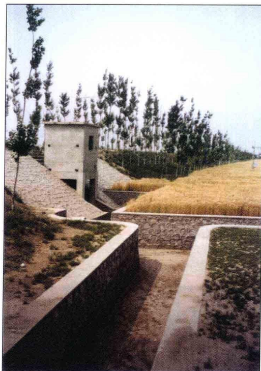
大石河芦村排洪泵站
