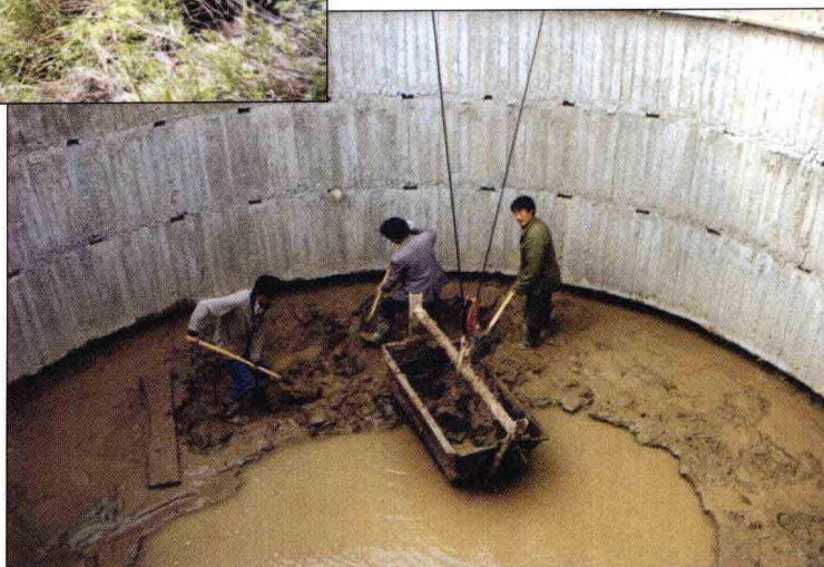
闫村镇张庄村挖抗旱大口井
