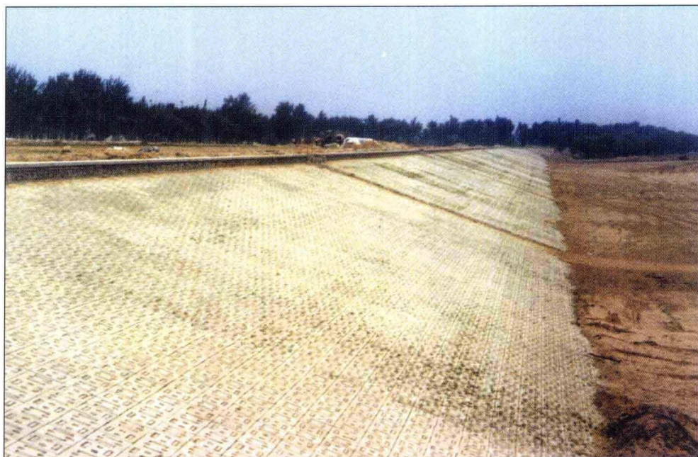
永定河公义庄段护砌工程
