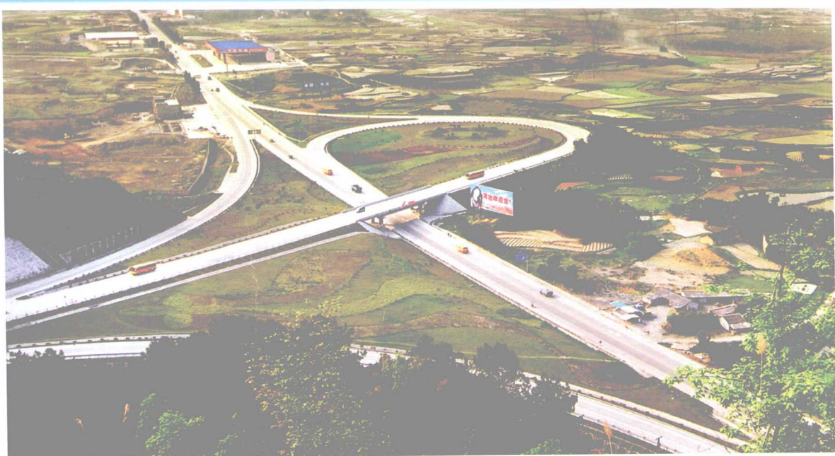
河池交通枢纽——水任至南宁高等级公路立交桥
